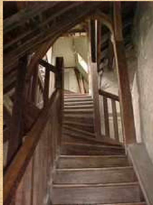
Escalier sur cour
